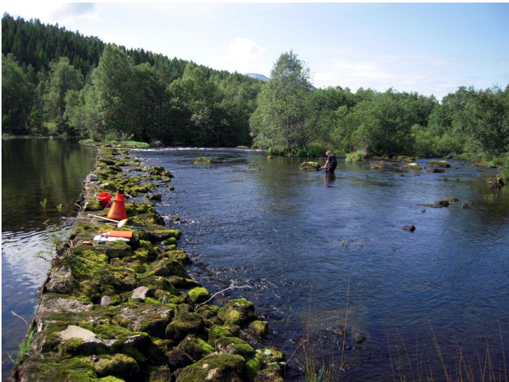
Øvre stasjon, Oselva
