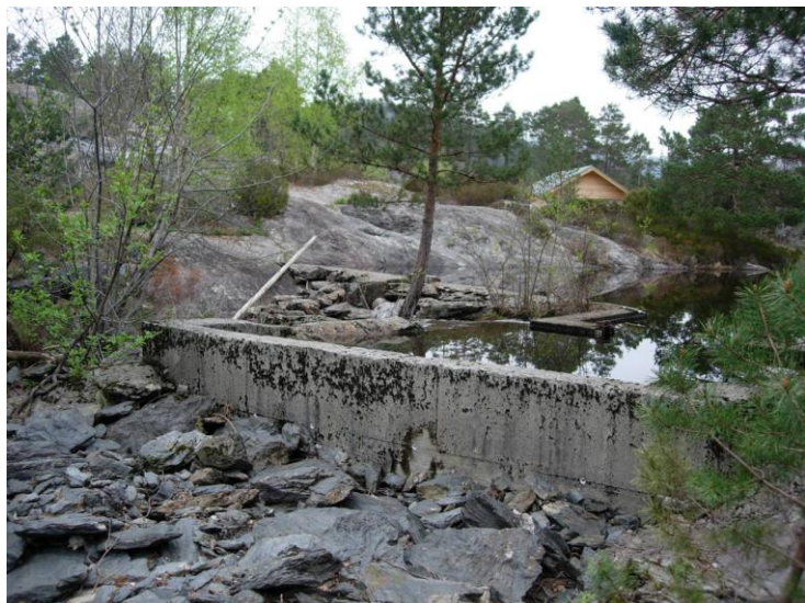
FIGUR 20. Demninga ved utløpet av Jagedalsvatnet.
