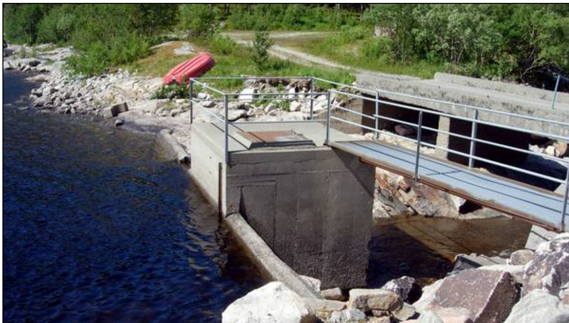
Figur 4. Demningen i utløpet av Slørdalsvatnet, med tappeluken for slipp av minstevannføring.
