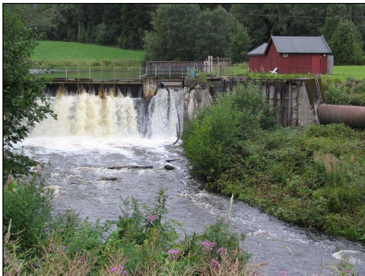
Figur 20. Reinsvolldammen er dannet som følge av en demning ved Reinsvoll. Rørgata går ned til et nedlagt kraftverk hundre meter lenger ned (august 2008). Foto: Bjørn Mejdell Larsen.
