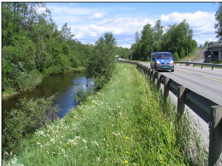
Figur 22. Vegen langs Hunnselva ligger flere steder på fylling helt ut i elvekanten, og både anleggsarbeidet og senere avrenning fra vegen kan ha gitt lokale påvirkninger på elvemuslingene som lever i elva. Foto: Bjørn Mejdell Larsen.
