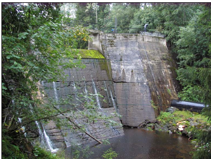
Figur 19. Demningen ved Vestbakken med rørgata ned til kraftverket (september 2008). Foto: Bjørn Mejdell Larsen.
