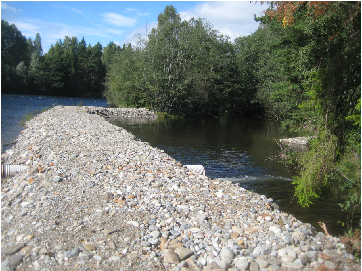
Figur 3. Sideløpet i Randselva som avskjæres av fyllingen. Gjennomstrømmingen skjer nå gjennom røret på bilde.
