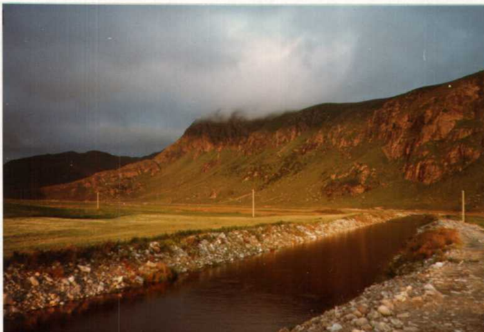
Fig. 6. Kanalen som i 1981 ble gravet for nedtappingen av vannet. Utsikt mot sørøst, mot Ervikvatn. 23.7.1983.
