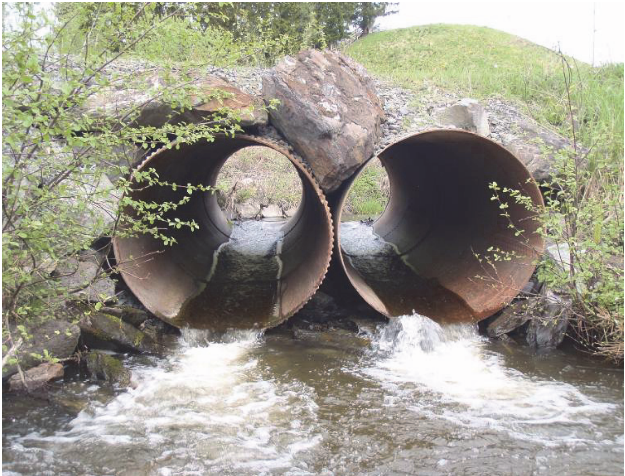
Bilde 6. Kulvert i Hofstadelvas nedre del ved lav vannføring. Foto: Morten Bergan.
