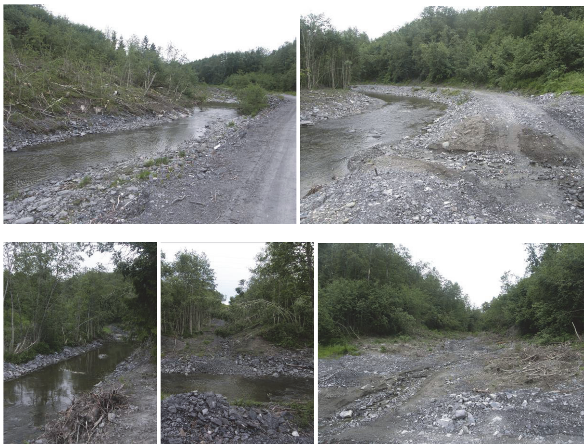
Bilde 3. Forbygningsarbeidet langs Gråelva har satt sine tydelige spor i elvekantskogen; mye av den opprinnelige elvekantskogen er erstattet med en steril anleggsveitrasé. Også sidebekkene er blitt kraftig ”plastret”, og elveløpet har fått lange partier med preg av kanalisering. Anleggsveien på den ene sida av elva legger beslag på betydelige arealer og vilthabitater, og forhindrer den naturlige direkte kontakten mellom kantskogen og elvestrengen. Foto: Per Gustav Thingstad.
