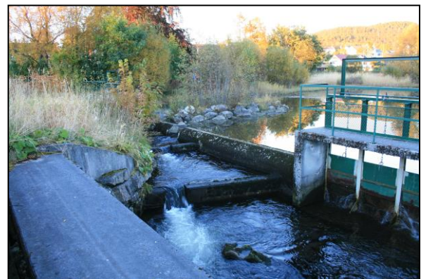
Fig. 10. Spjolkavikelva har to kritiske passasjer for oppvandrende fisk. Til venstre : Betongkonstruksjon nedenfor tunell under butikkssenter gir svært dårlig oppvandring ved lave vannføringer og bør bygges om snarest. Til høyre : Fisketrapp i utløpet av Lillevatn gir god oppvandring av gytefisk.
