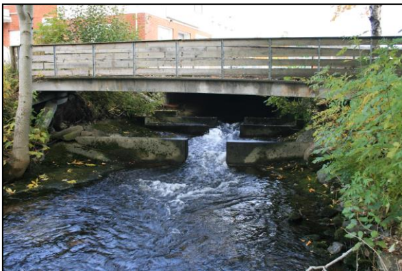
Fig. 10. Spjolkavikelva har to kritiske passasjer for oppvandrende fisk. Til venstre : Betongkonstruksjon nedenfor tunell under butikkssenter gir svært dårlig oppvandring ved lave vannføringer og bør bygges om snarest. Til høyre : Fisketrapp i utløpet av Lillevatn gir god oppvandring av gytefisk.
