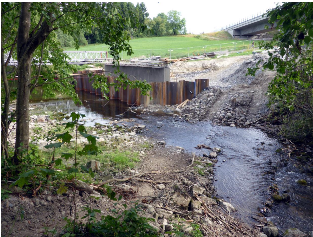
Figur 6. Fra anleggsarbeidet ved ny Gutugata bru i Sande kommune. Dette partiet ble også undersøkt tidligere i 2014. Foto: Kjell Sandaas.
