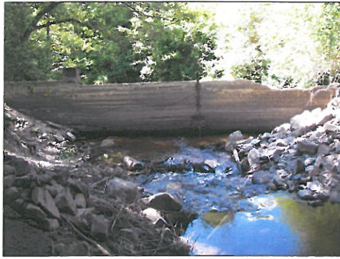
Fig. 5. Demningen ved Vegger (vannsiden).
