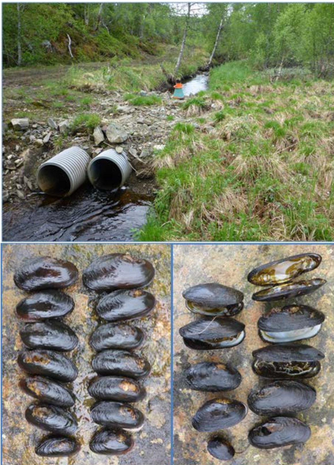
Figur 14. Øverst: Gjøvassbekken(Fuggelåsbekken) med kulvert som er underdimensjonert og kan hindre passasje for vertsfisk ørret (yngel og ungfisk). Nederst t.v: Utvalg av levende muslinger, hvorav ingen rekrutter <50 mm. Nederst t.h: Utvalg skall med enkelt individer <50 mm. Bestanden har nylig hatt stor dødelighet for alle størrelser (aldersgrupper) (Foto HBE).
