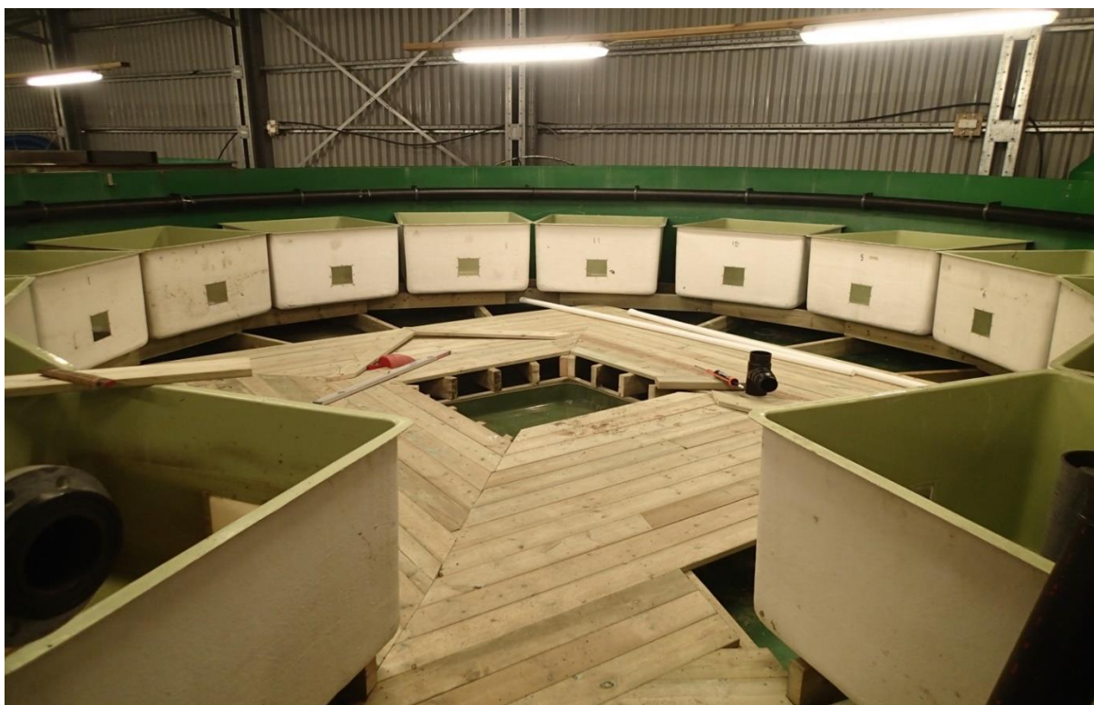
Figur 45. Ny enhet bestående av 14 nye kar for oppbevaring av infisert fisk, er under oppbygging.
