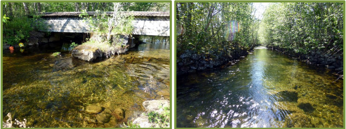
Figur 10. Fra stasjon 5, rørgate over elva, der de fleste og minste muslingene ble funnet og infeksjonsgraden på ørretungene var høyest. Foto til høyre viser et fint parti av elva like nedstrøms denne stasjonen. Kanalisering og steinsetting av elveløpet synes godt. Foto: Kjell Sandaas 2013.
