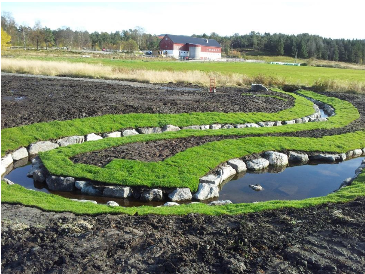
Eksempel på tiltak, anlegg av elvemusling-kanal i Haukåsvassdraget i Bergen. Foto: Håvard Bjordal
