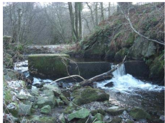
Fig. 2 Demningen ved inntak til Nordåsvannets dype soner: Virker som vandrehindring under lav vannføring i dag.
