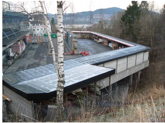
Fig. 4 Dette var en gang en elvedal. I dag renner elven i kulverten under kjøpesenteret i Nordåsdaalen
