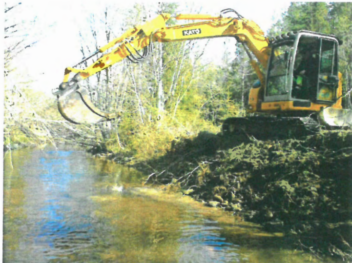
Figur 1. Gravemaskin legger ut stein som biotopjusterende tiltak i Drakstelva.
