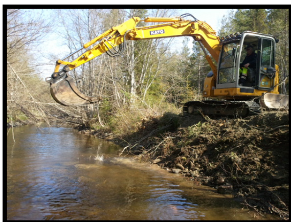
Figur 4. Bilder fra tiltaksområdet. Venstre bilde viser utlegging av masser i elven, mens høyre bilde viser elvebunn etter at massene er utlagt
