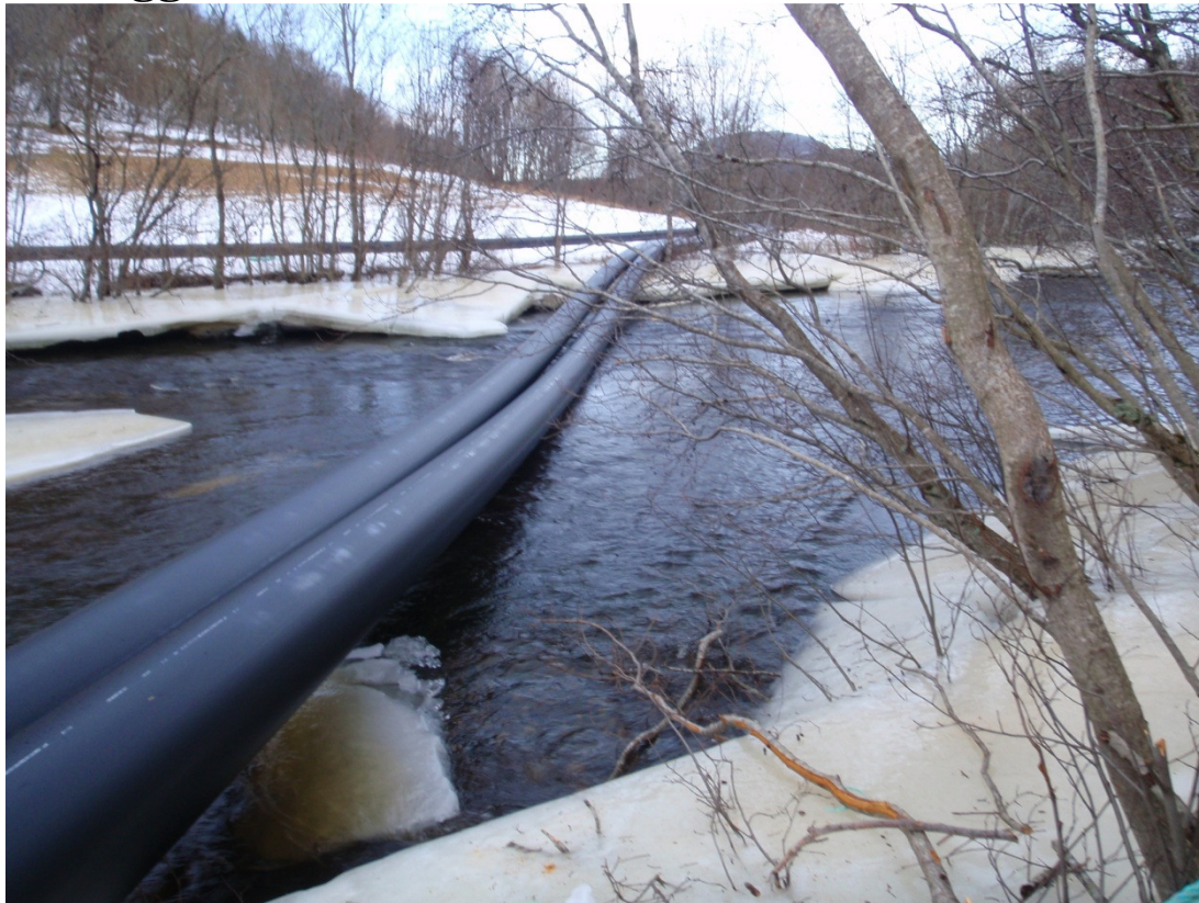
Oversikt ved rørtraséen. Røret skal graves ned et stykke til høyre for rørene som ligger der.
