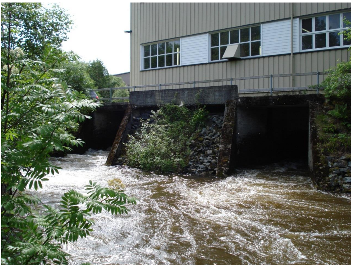
Bilde 3 Utløp Teksdal kraftverk.
