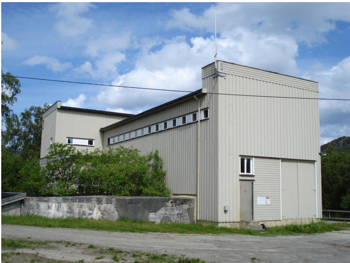
Bilde 2 Teksdal kraftstasjon.
