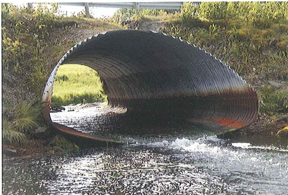
Figur 4. Kulvert ved utløpet av Bergselva.
