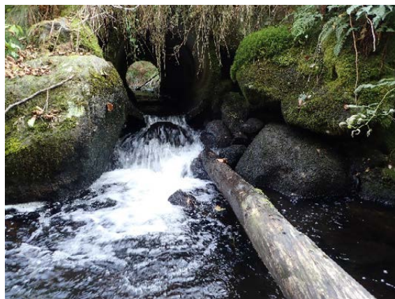
Bilde 18. Kulvert under veien ved Vassbotn gård. Foto: Bjørn Mejdell Larsen.
