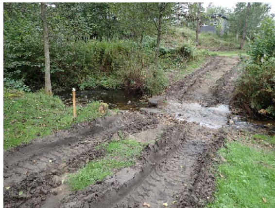
Bilde 22. Kjøring i Møllebekken skaper erosjonsproblemer, ved terrasseblokk ved Berse. Foto: Bjørn Mejdell Larsen.
