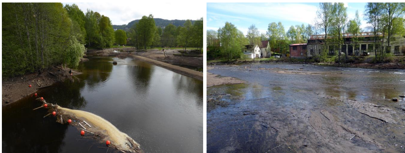
Figur 2. Til venstre Brekkedammen under nedtapping sett fra gangveien på damkronen. Til høyre øvre del av dammen som pga synkende vannstand blottlegges og «gjenoppstår som strykpartier». Sedimentene får nå en hardt tiltrengt gjennomspyling under anleggsperioden. Foto: Kjell Sandaas 2016.
