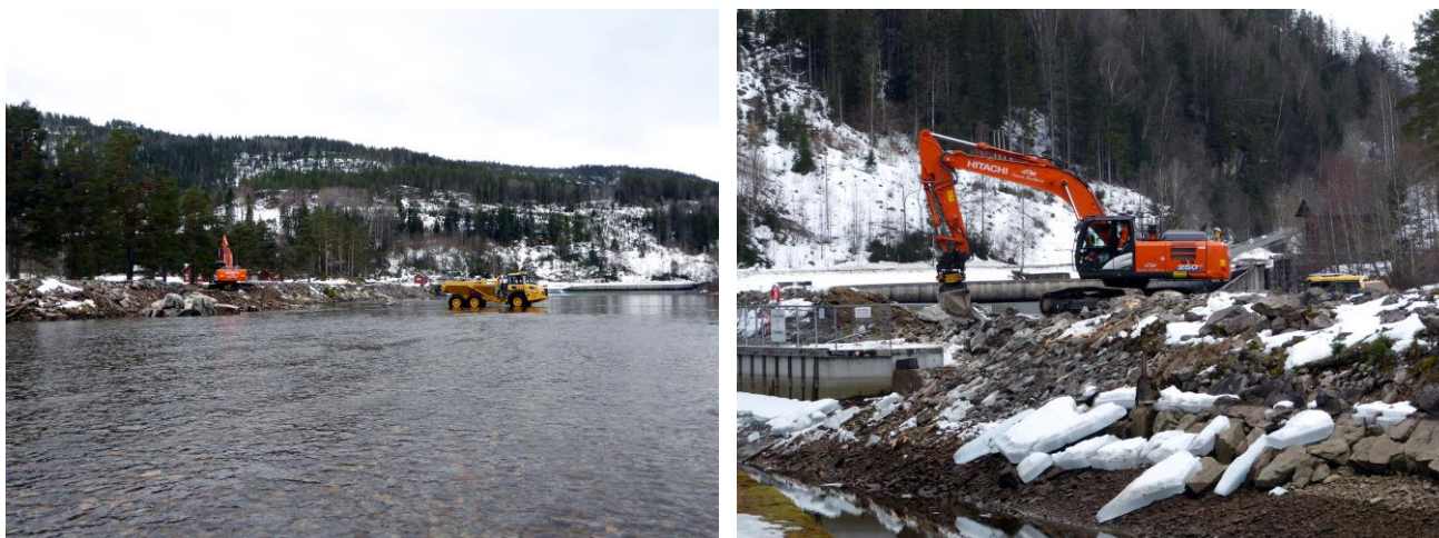
Figur 4. Bildene over viser anleggsarbeidet som foregikk i elva mens undersøkelsen pågikk. Ødelagte muslinger etter anleggsarbeidet ble ikke funnet. Foto: Kjell Sandaas 2017.
