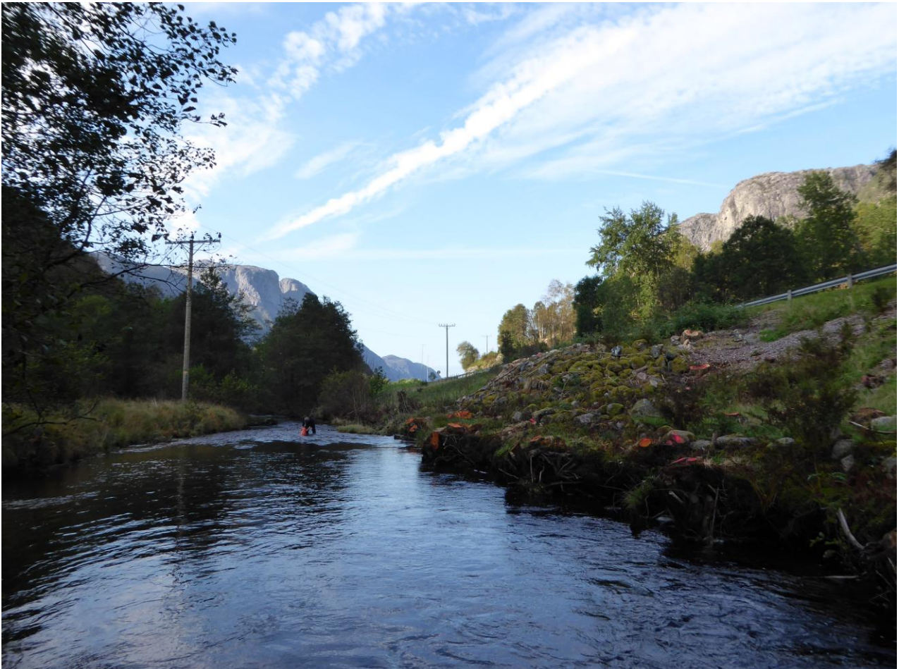
Figur 9. Fysiske inngrep som er uheldige for alt liv i elva, forekommer stadig uten nødvendige hensyn. Her er all kantvegetasjon langs bredden av Spjodåna nylig hogd på en strekning som er svært egnet som gyte- og oppvekstområde for laksefisk. Foto: Kjell Sandaas 2016.
