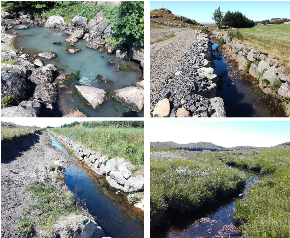
Figur 4.5 Øverst t.v.: Øvre del av stasjon 14 var sterkt preget av avrenning av partikler og næringsalter fra nydyrkingsflaten lenger oppstrøms. Øverst t.h.: Avrenning fra et nydyrket område (til venstre for veien) ledes via rør til den kanaliserte delen av bekken. Nederst t.v.: Erosjon på sørsiden av kanalen oppstrøms nydyrkingsfeltet fører til at kantene raser ut. Nederst t.h.: Stasjon 16
