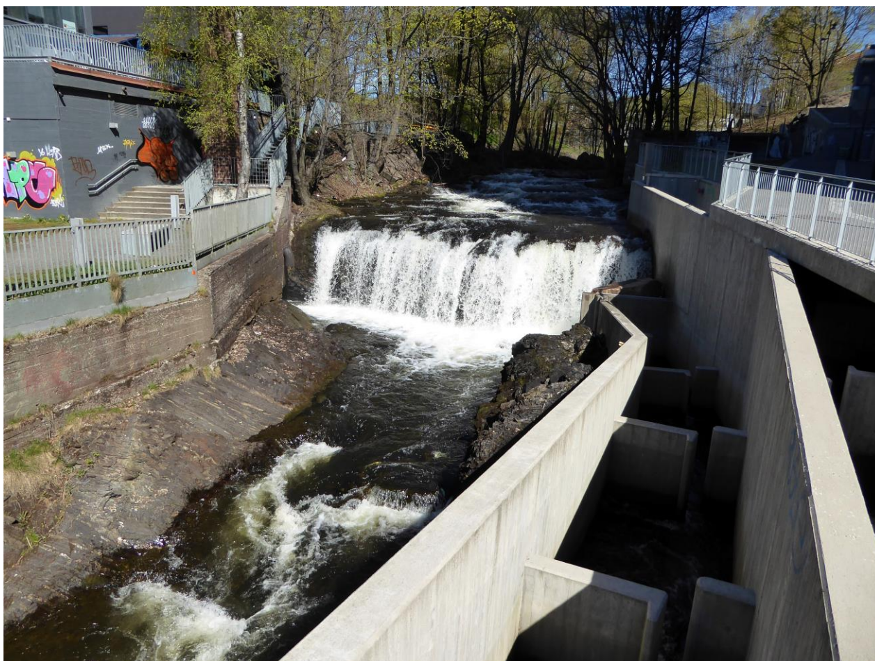
Figur 3. Foto viser stryket ved foten av Nedre Foss som er det naturlige vandringshinder for anadrom fisk. Fiskepassasjen til høyre i bildet åpner nå for at gode gyte- og oppvekstområder opp til Seilduksfossen er tilgjengelig for laks og sjøørret. Foto: Kjell Sandaas, 2017.
