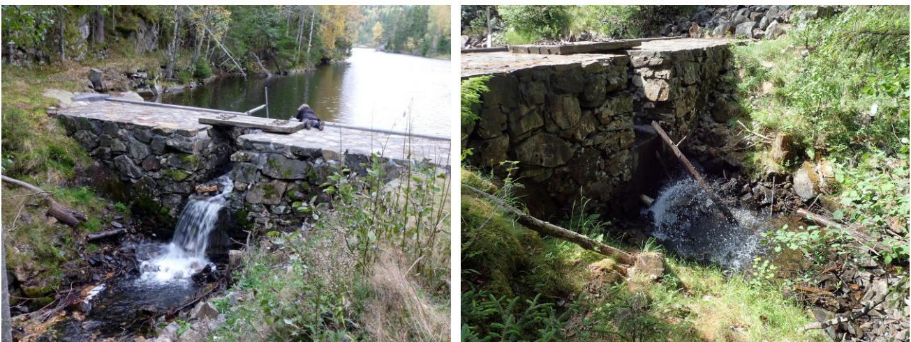
Figur 5. Til venstre Raudsjødammen etter rehabilitering. Røret synes så vidt bak fossen. Til høyre Raudsjødammen i 2018. Røret slipper ut nok vann til at vannføring var tilstrekkelig sommeren 2018. Foto: Kjell Sandaas 2009 og 2018.
