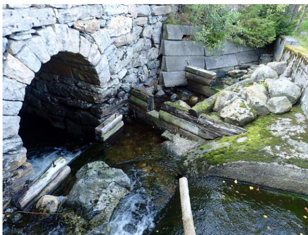
Figur 2. Til venstre Ørelva rett før samløpet med Enningdalselva og til høyre fra utløpet av Ørsjøen med synlige rester av gamle fisketrapper i tømmer.
