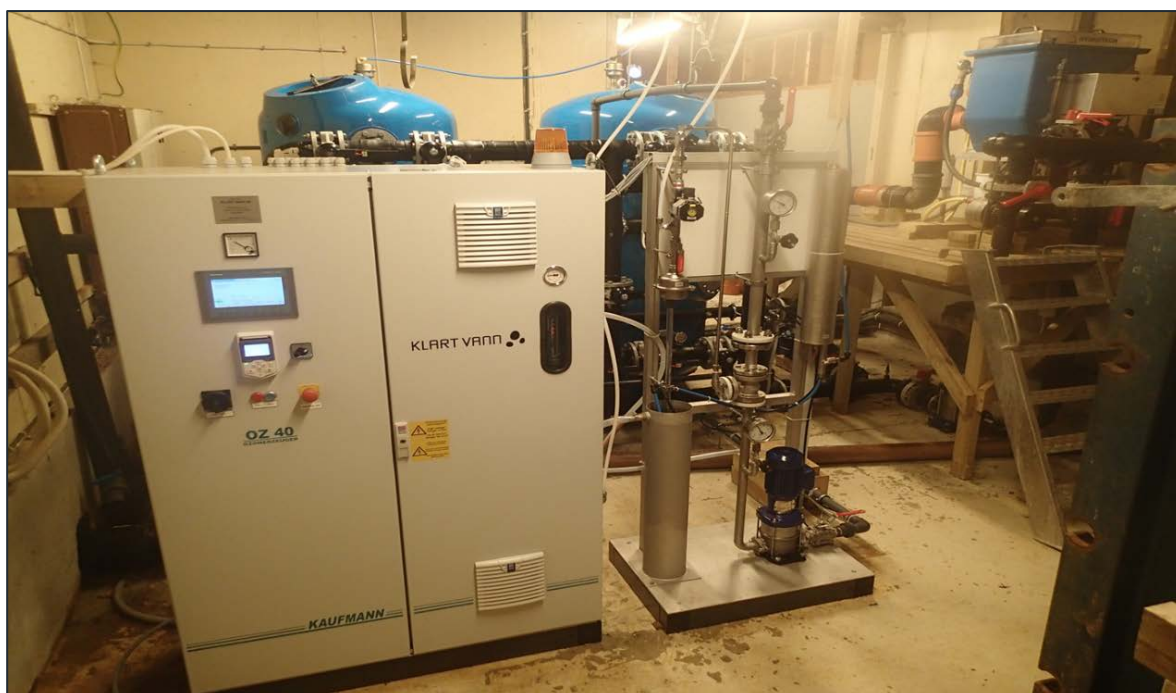
Foto 2. Vannbehandlingsanlegg for muslinger produsert i anlegget. Anlegget består av ozoneringsenhet i front og AFM filtre (blå tanker bak). Vannet til filterene er forhåndsfiltrert med et trommelfilter som fjerner partikler over 40 mikrometer. Vannet blir deretter pumpet inn til AFM- filterene som inneholder resikulert glass. Disse er svakt negativt ladd og binder også tungmetaller i tillegg til filtrasjon av cyanobakterier ned til 5–6 mikrometer. Filterene blir tilført ozon øverst for å desinfisere filtermassen. Dette for å forhindre tilførte patogen med størrelser under 5–6 mikrometer, som er minste filterstørrelse. Filteret regenereres ved å pumpe vann (35 m 3 /time) fra bunnen og opp. Dette fjerner bundne tungmetaller og organisk materiale filtrert fra inntaksvannet. Anlegget er levert av Klart Vann AS.
