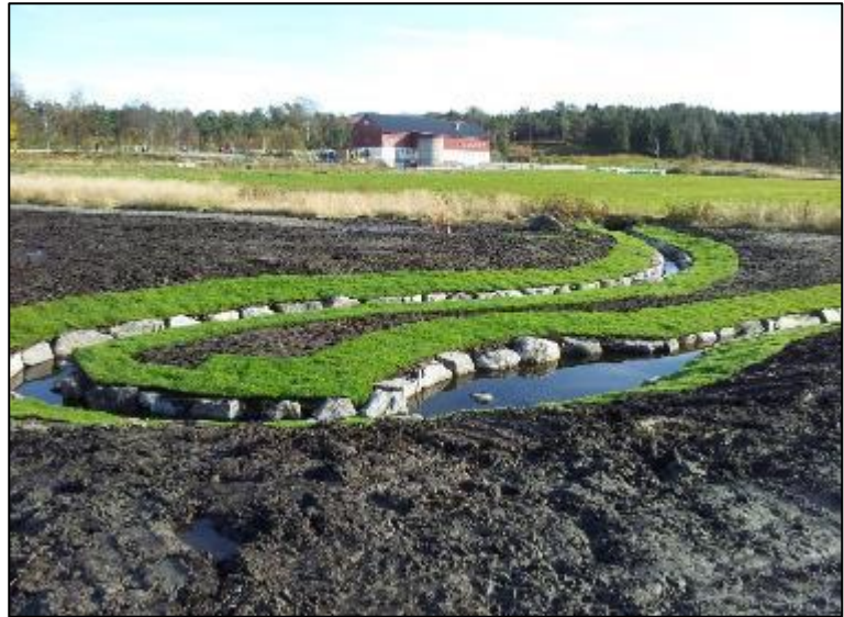
Figur 25. «Meanderen», det kunstige meandrerende elveløpet, som er etablert på Haukåsmyrene.
