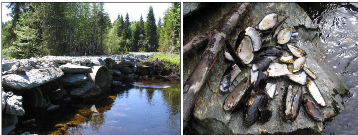
Figur 9. Brekkelva ble lagt i rør, og den midlertidige kjørettraséen krysset elva i fylling som medførte høy dødelighet på muslinger i området. Foto: Bjørn Mejdell Larsen.
