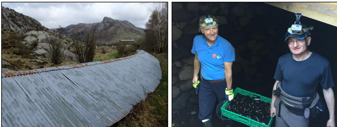
Figur 7. Svilandskanalen, som overfører vann fra Skjelbreidtjørn til Sviland kraftverk, er dekket med tak av bølgeblekk på hele den om lag 1,8 km lange strekningen. Foto til venstre: Bjørn Mejdell Larsen. Ved innsamling av elvemusling i inntakskanalen var det nødvendig med hodelykt. Foto til høyre: Trond Erik Børresen, Lyse Produksjon AS.
