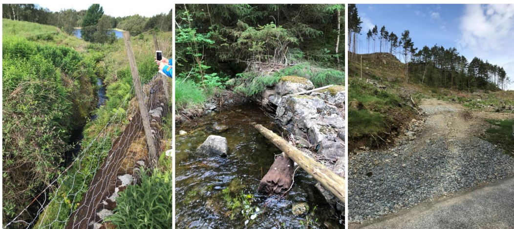
Figur 10. Til venstre: kanal som renner ut i Oldereidtjørna. Midten: rester etter gamle bru nedstrøms VA-anlegg i Åreiddalselva. Til høyre: hogstfelt vest av Finnåsvatnet.
