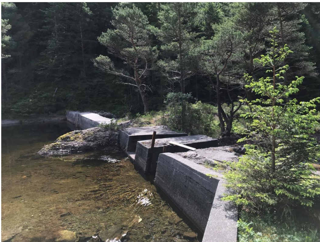
Figur 8 Damanlegg ved utløpet av Finnåsvatnet. Overløp/innløp ses i forgrunnen og bunntappeluka finnes i dammen i bakgrunnen.
