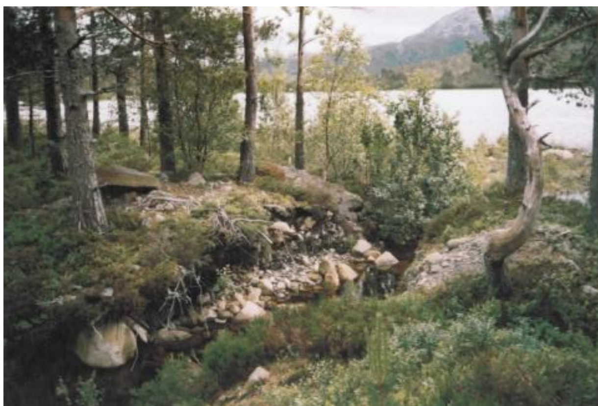
Bilde 2: Graving gjort for å tappe ned vatnet.
