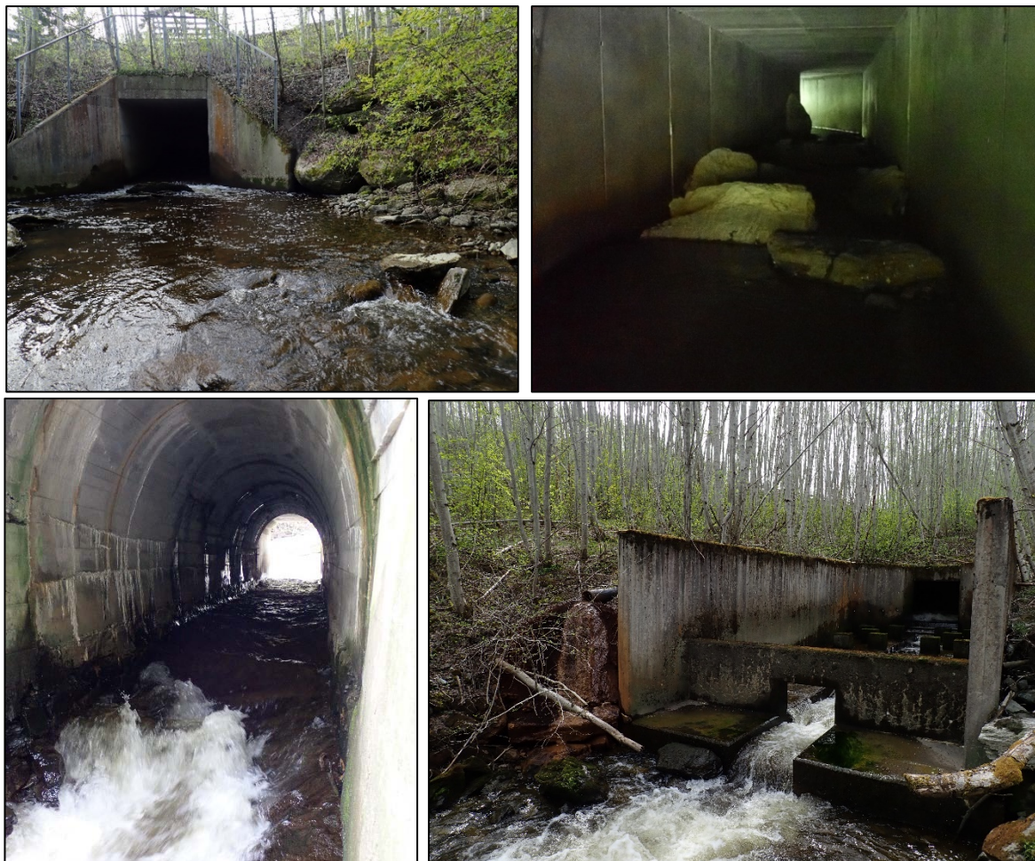
Figur 13. Kulverter og passasjer som ørret må passere på opp- eller nedvandring i Sagelva under jernbanen (bildene øverst), under Rv 705 (til venstre nede) og under nåværende E6 (til høyre nede). Foto: Bjørn Mejdell Larsen.
