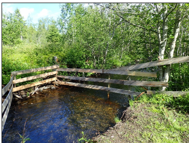
Figur 46. Opparbeidet drikkeplass for beitedyr i Sagelva. Dette reduserer faren for erosjon og avrenning og begrenser slitasje og tråkk i elveløpet. Foto: Bjørn Mejdell Larsen
