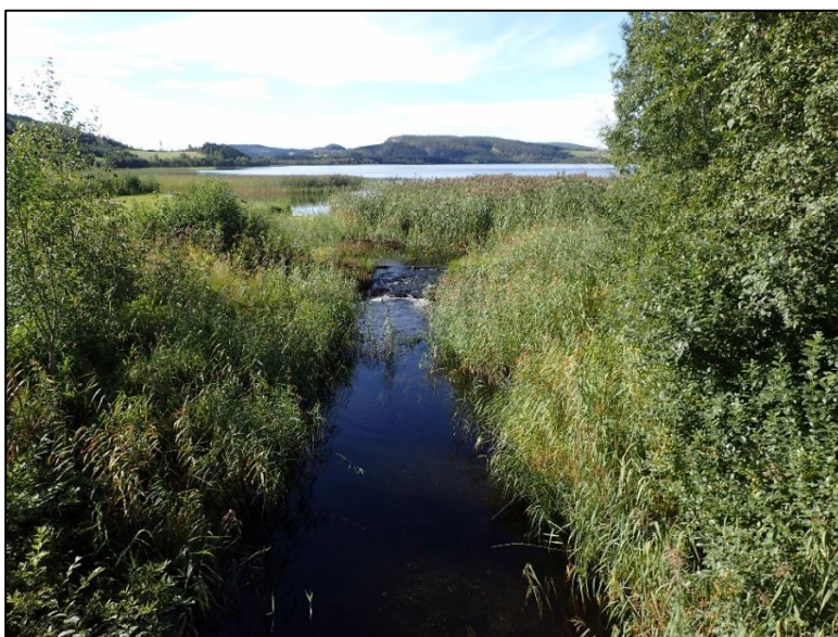
Figur 11. Utløpet av Lømsen er gravd ut og «kanalisert» på en kort strekning i forbindelse med tidligere senkning av vatnet. Senere er det anlagt en terskel ved utløpet for å heve vannspeilet tilbake til kote 38,55 m. Foto: Bjørn Mejdell Larsen.
