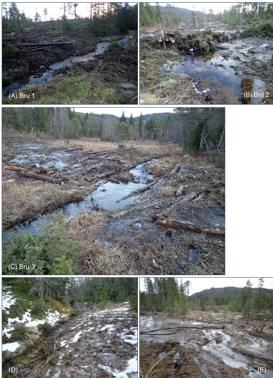
Figur 2. De tre provisoriske brupunktene for kryssing av Vålvasselva (Bru 1, 2 og 3 – ovenfra og nedover (foto A, B og C), jf. figur 1). Bru 1 og 3 var fjernet i desember mens bru 2 fortsatt var intakt. De nederste bildene viser avrenning av løsmasser via oppdemte områder (dammer) som førte til ras og utglidning av masse mot vassdraget (foto D og E). Foto: Bjørn Mejdell Larsen.
