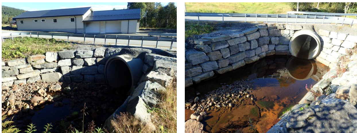
Figur 3. Til venstre kulverten oppstrøms veien og til høyre den samme kulverten nedstrøms veien. Foto: Kjell Sandaas 02.05.2022.
