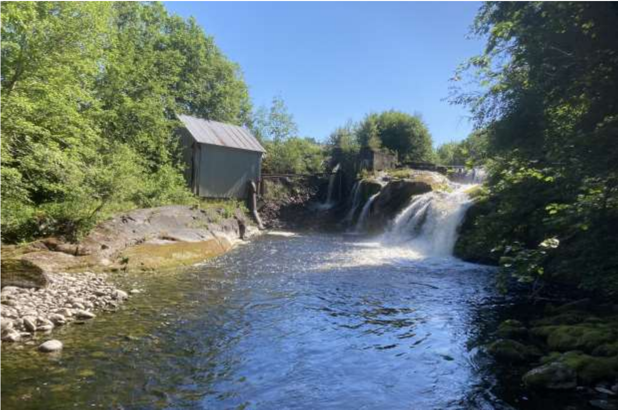
Rester av gammelt kraftverk ved Fossingan.
