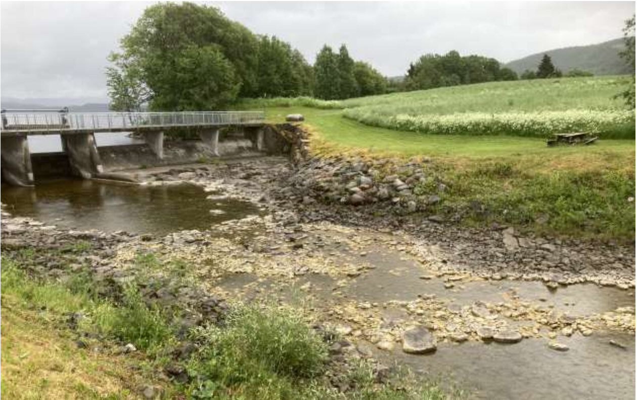
Tørrlegging ved utløpet av Hoklingen.
