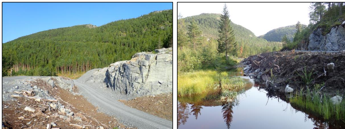
Figur 10. Utbedring av vegnettet langs vassdraget har gitt tydelige terrengskader og utfordringer med avrenning mot vassdraget. Foto: Bjørn Mejdell Larsen.
