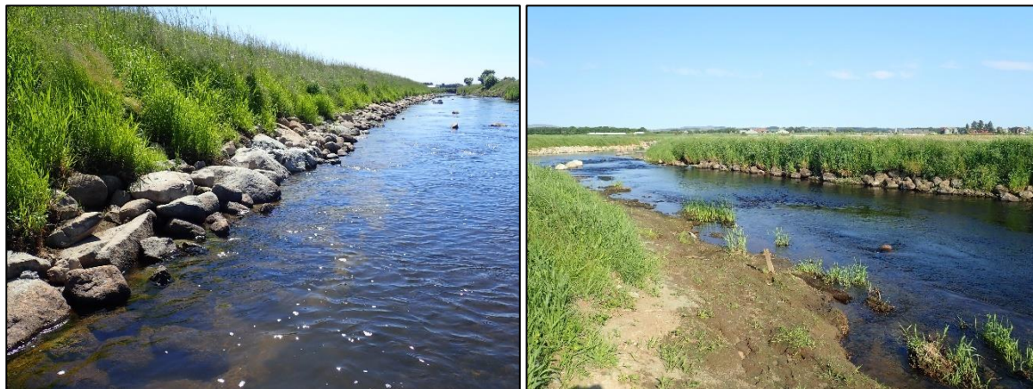
Figur 55. Det ble gjennomført et omfattende gravearbeid i Håelva i 2019 og 2020 med restaurering og gjennomføring av habitattiltak på hele strekningen fra Haugland til Kaffiholen (inkluderte stasjon 7 og 8 i overvåkingsprogrammet). Elvekanten skulle sikres og masse ble fjernet for å lage slakere elveskråninger. Noen steder ble også den nederste delen av skråningen steinsatt. Foto: Bjørn Mejdell Larsen.
