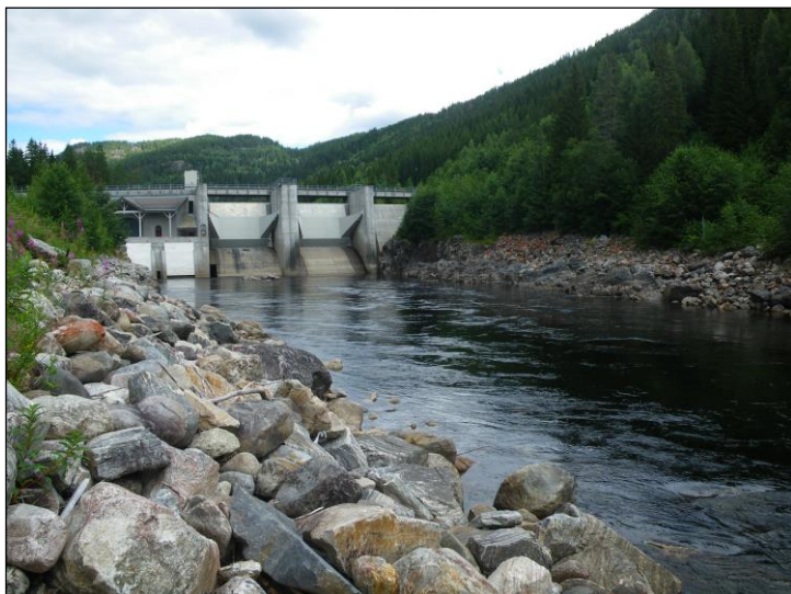
Figur 6. Et elvekraftverk medfører en langvarig endring av elveløpet som også omfatter kanalisering nedenfor kraftverket og heving av vannstanden i ovenforliggende elvestrekning. Foto: Bjørn Mejdell Larsen.
