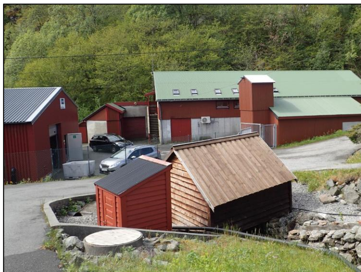
Figur 3. Prosjektet «Storskala kultivering av elvemusling som bevaringstiltak» gjennomføres i et tidligere smoltoppdrettsanlegg på Austevoll, eid av Lerøy Vest A/S. Foto: Bjørn Mejdell Larsen.
