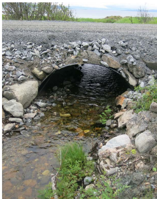
SVV med fullt passerbare kulverter (Haugland & Hjelle 2015)
