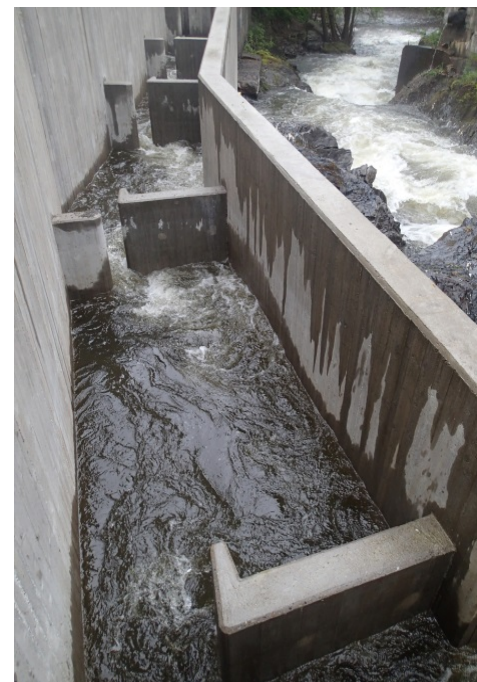
Spaltetrapp i Akerselva
