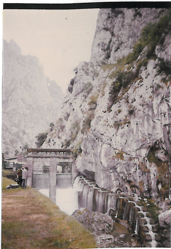
Kraftutbygging og laksetrapp øverst i rio Cares.
