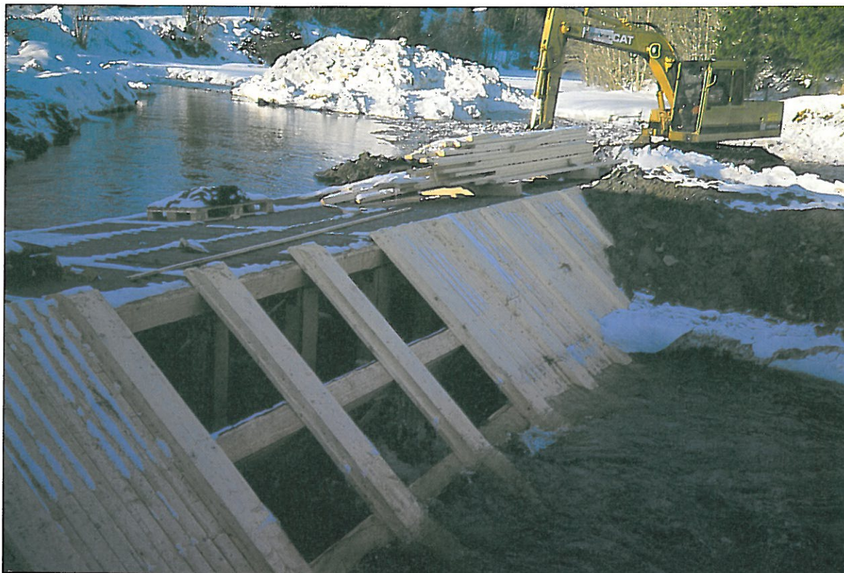
Huden ble pålagt seksjonsvis mens vatnet ble ledet vekk. Vinkelen mot vannivået er ca. 35°. Tykkelsen på huden er 48 mm og den har holdt flere isganger.
