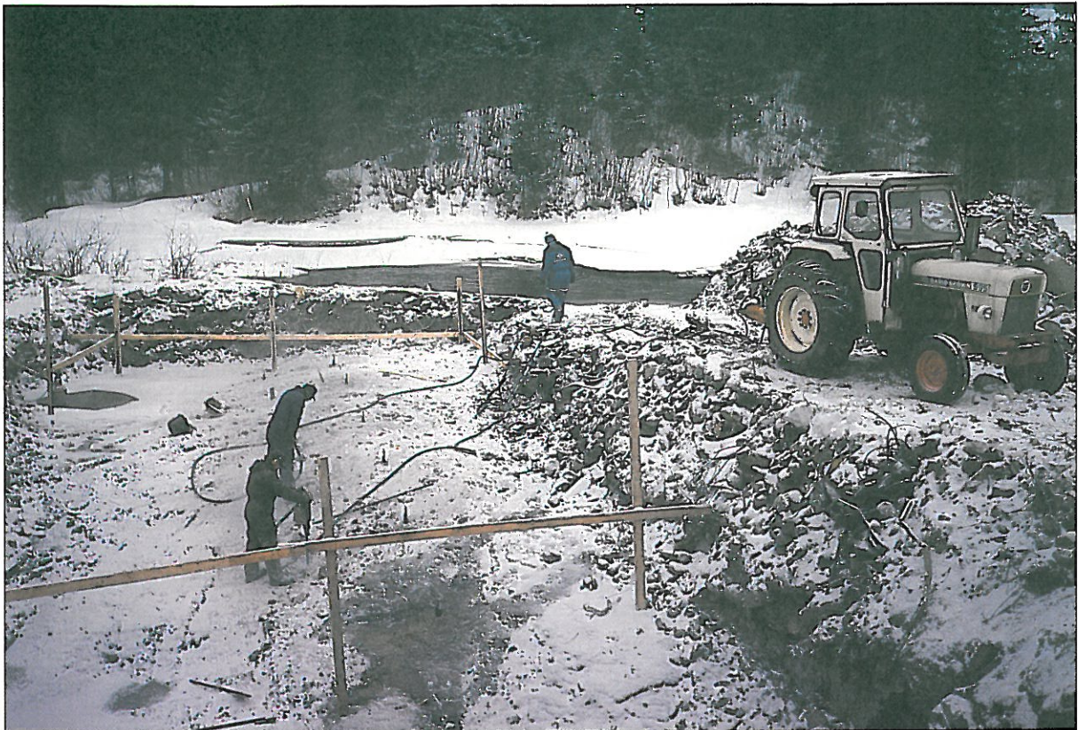
Stedsvalget for plassering av fiskesperra var viktig. Stedet måtte ligge langt ned i vassdraget og helst i forbindelse med et naturlig fall. Det var også viktig å forankre sperra til fast fjell.
