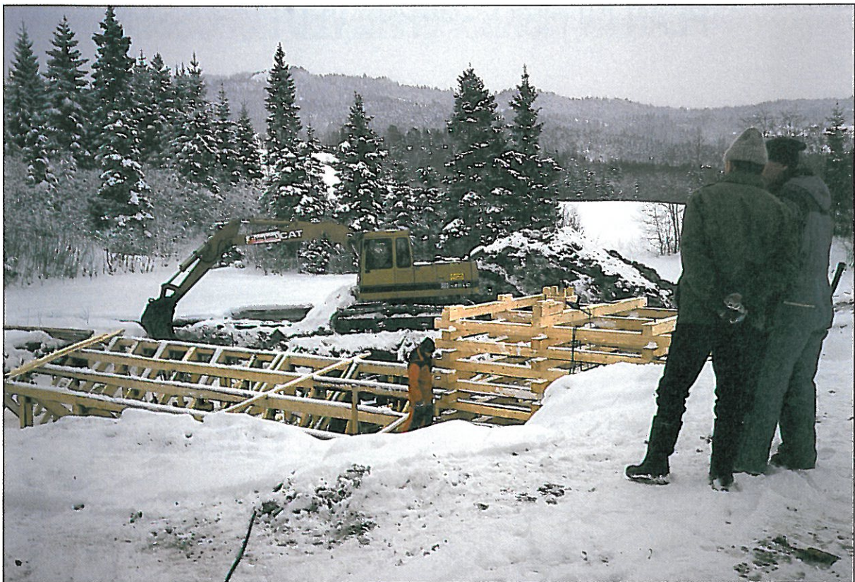
Fiskesperra i Figga ble bygd i grovt treverk (20x20 cm) med tømmerkasser fylt med stein på hver side, omtrent som en gammeldags fløtningsdam.
