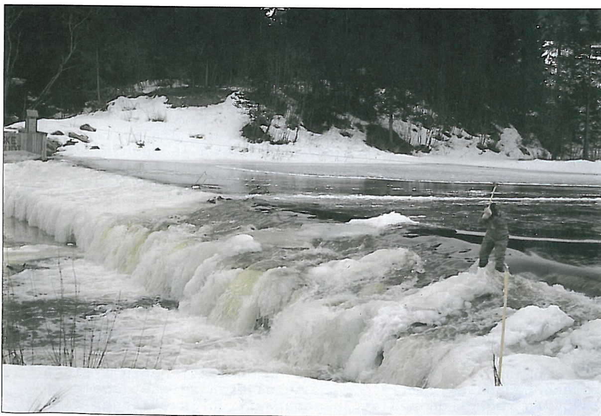
Største vedlikeholdsproblemet med sperra har vært ising. Dette skjer når elva går åpen samtidig som det er kulde. Vatnet blir underkjølt, gitteret går tett og det bygger seg opp isdemning på sperra. I ett tilfelle måtte isen sprenge vekk. Situasjonen stabiliserer seg raskt når isen legger seg på elva.
