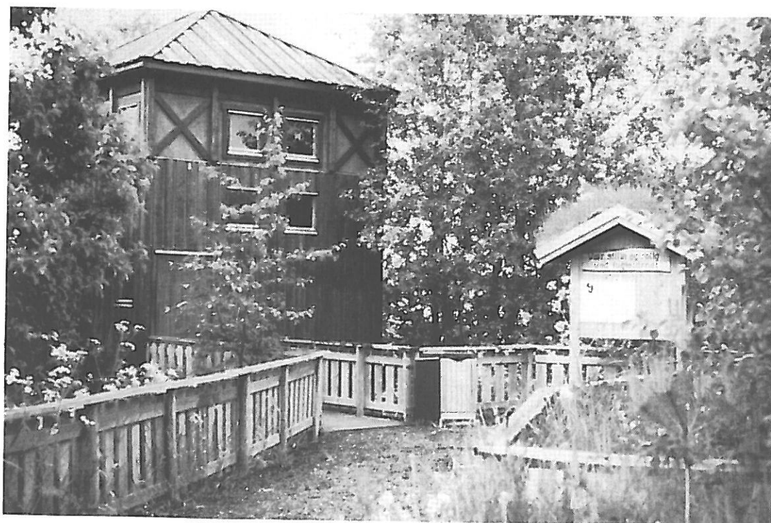
Figur 3. Tårnet og inngangsparti sett fra gangstien inn mot tårnet juni 1993. Foto Magne Husby.
