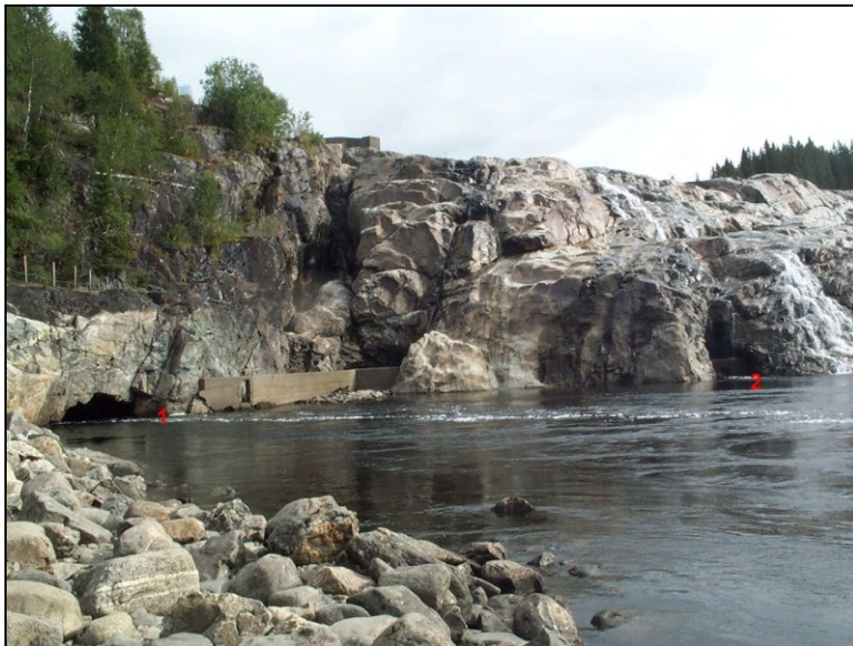
Nedre Fiskumfoss. 1 viser utløp av kraftstasjonen, 2 viser østre inngang til laksetrapp
