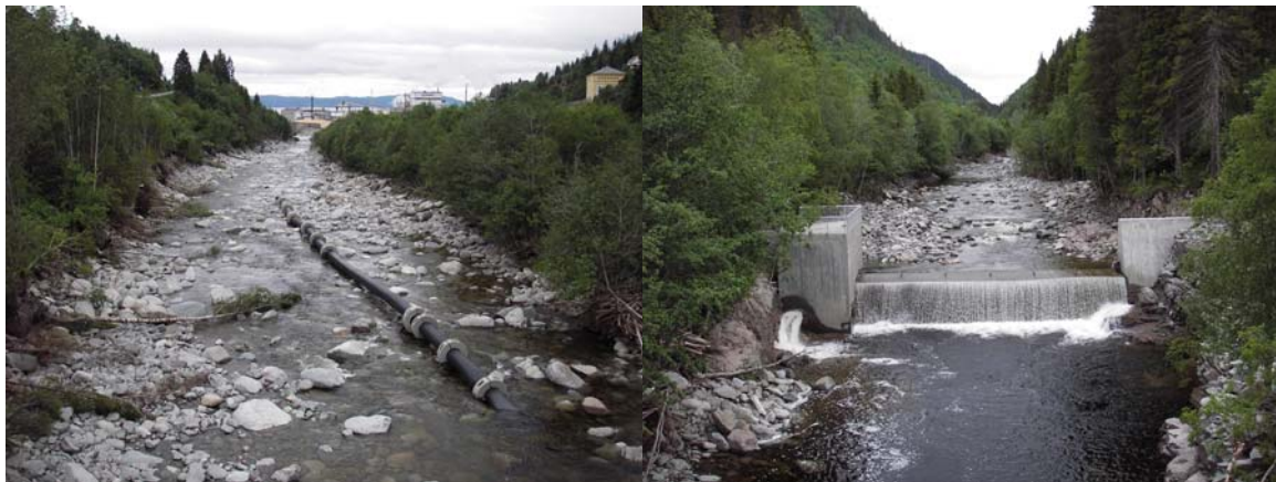
Follaelva sett fra fylkesvegbrua, nedstrøms til venstre og oppstrøms til høyre.
