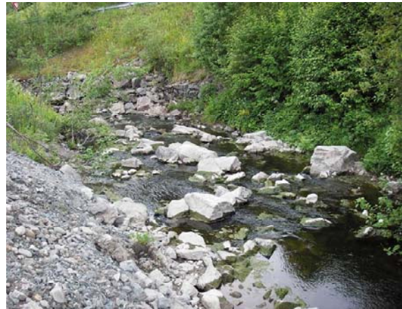
Fra nedre deler av Ressemelva.
