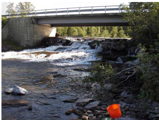
Fossen under riksvegen
