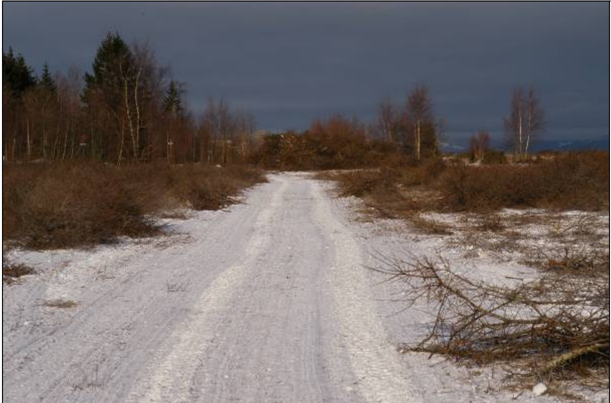
En gammel "tanksveg" ble brukt for å samle det meste av kjøringen, og viste lite tegn til slitasje.
