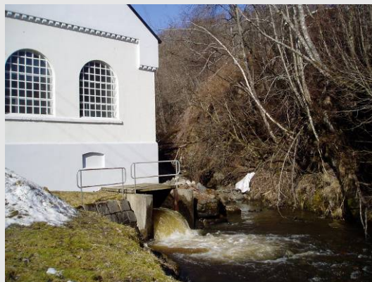
Ullvilla kraftstasjon. Vassdraget er regulert av Nord-Trøndelag E-verk.
