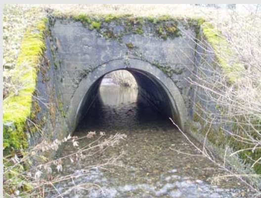
Kulvert under avlingsvei.
