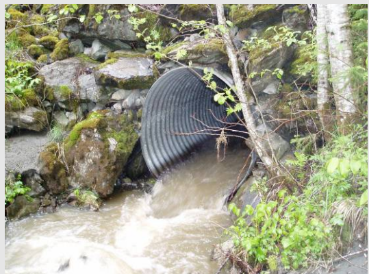
Kulverten ved utløpet til Verdalselva.
