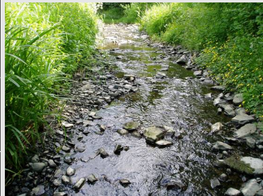
Bekkeløpet er plastret med stein.
