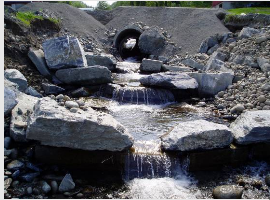
Grunneier har anlagt fisketrapp nedenfor kulvert.
