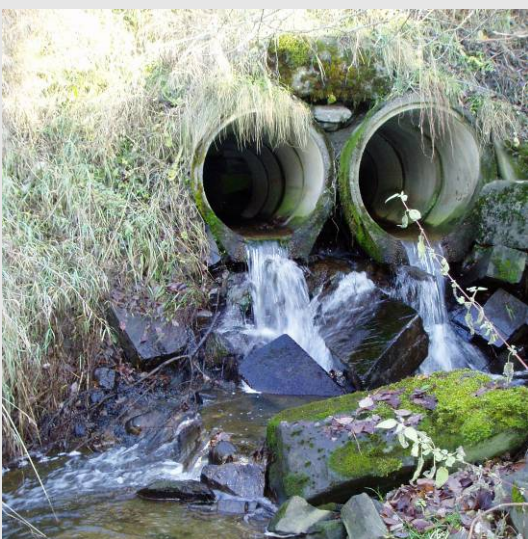
Kulverten i riksveien er dårlig tilpasset gytevandrene sjøaure.
