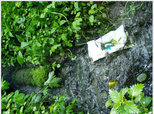
Kloakkvann fra en husstand like ovenfor riksveien føres urensset til bekken.
