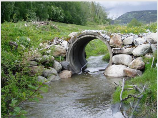
Kulvert i gammel avlingsvei.
