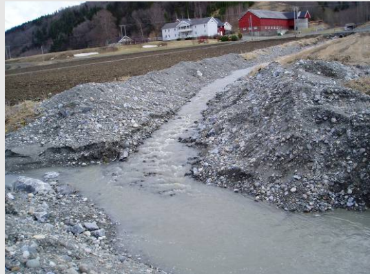
Den omlagte delen av bekkeløpet.
