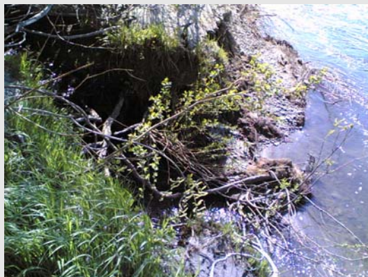
Utløpet til Verdalselva har flyttet seg ca. 100 meter nedstrøms.
