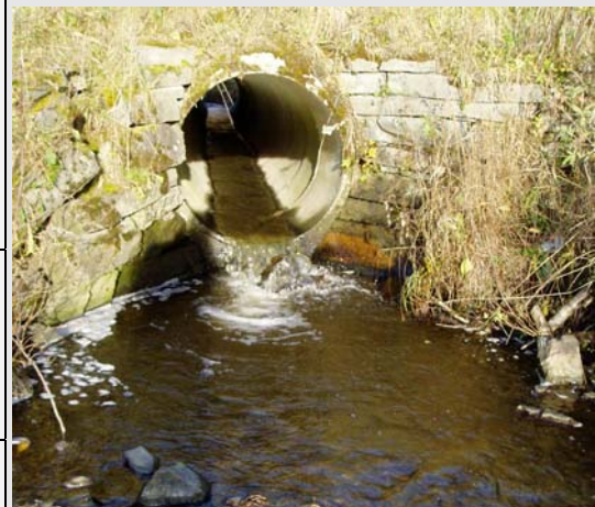
Kulverten under veien i RV. 757.
